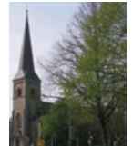
Kirche St. Georg in Heisingen Heisinger Str. 478 45259 Essen
