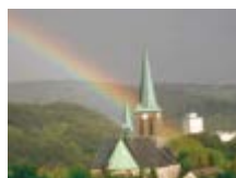
Kirche St. Mariä Geburt in Dilldorf Dilldorfer Str. 34 45257 Essen
