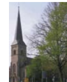
Kirche St. Georg in Heisingen Heisinger Str. 478 45259 Essen
